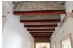
Verstärkungen Flur Achse C - D
