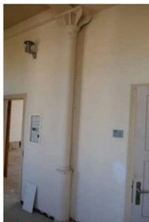
Stahlstütze in der Achse 406
