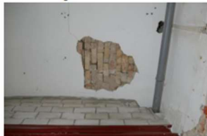
gestörtes Gewölbemauerwerk
