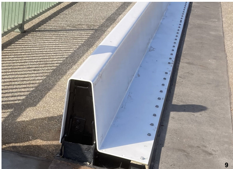
Bildverzeichnis: 1+2 Fehmarnsundbrücke; 3 Zustand der Verankerung der Unterkonstruktion vor Sanierung; 4+5 neue Leitschwelle (West); 6+7 neue Unterkonstruktion; 8+9 neue Abdeckhauben West (mit Unterkonstruktion)
