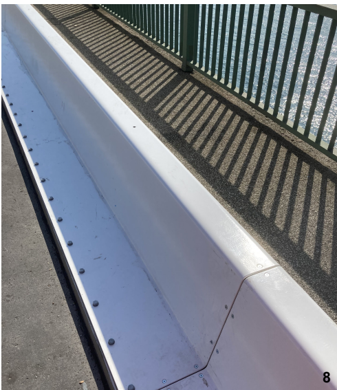
Bildverzeichnis: 1+2 Fehmarnsundbrücke; 3 Zustand der Verankerung der Unterkonstruktion vor Sanierung; 4+5 neue Leitschwelle (West); 6+7 neue Unterkonstruktion; 8+9 neue Abdeckhauben West (mit Unterkonstruktion)
