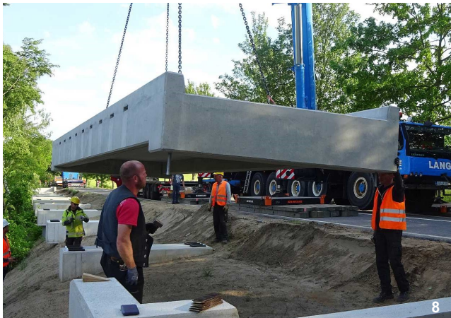
Bildverzeichnis: 1. Achse 10, Blick Richtung Feldberg 2. Seitenansicht Ost 3. Längsschnitt und Grundriss der Ausführungsplanung 4. Einbringen der Stahlrohrramppfähle 5. Herstellung des Auflagerbalkens Achse 100 6. fertiggestellte und hinterfüllte Auflagerbalken 7. Widerlager Achse 110 mit angebundenem Stützbauwerk 8. Montage der Überbauteile 9. Böschungsbefestigung mit Gabionen und Wasserbausteinen
