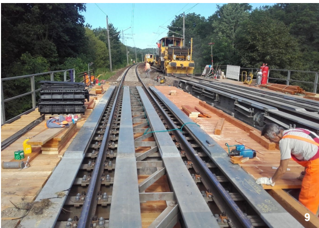
Bildverzeichnis: 1. eingebaute Hilfsbrücken nach der Fertigstellung 2. Anfahrtschaden am Längsträger 3. Bauwerk mit Bestandsüberbauten 4. freigelegte Tröge der Bestandsüberbauten 5. nächtliche Demontage (Aushub) der Bestandsüberbauten 6. Vorbereitung der Bestandswiderlager 7. eingebaute Auflagerträger 8. nächtliche Montage (Einhub) der Zwillingsträgerhilfsbrücken (ZH) 9. Herstellung Gehwegausbohrung 10. Ansicht Auflagerbank
