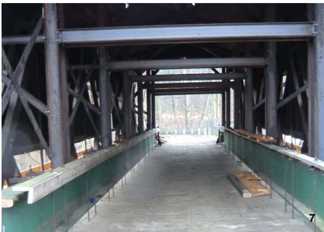
Bildverzeichnis: 1. Hausbrücke Ahrensberg 2. geplanter Querschnitt 3. stirnseitige Ansicht (fertiggestellt) 4. Fachwerk der Hausbrücke (instandgesetzt) 5. Längsschnitt: Planung zu ersetzenden Bauteile 6. Längsschnitt mit Hilfskonstruktion 7. Sicherung der Hausbrücke durch Stahlkonstruktion (Entlastung des Tragwerkes) 8. Freigelegte Tragkonstruktion
