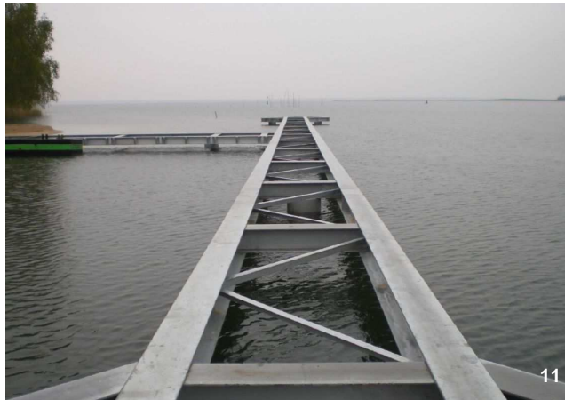
Bildverzeichnis: 1. Ansicht fertige Anlage mit Zuwegung 2. fertige Anlage mit Strandbereich 3. Steg 2 mit Badeplattform 4. Steg 1 (Landungssteg) 5. Badeplattform mit Sprungbrettanlage 6. Steg 1 - Trägerkonstruktion 7. Steg 2 mit Bohlenbelag 8. - 10. Konstruktionszeichnungen 11. Steg 2 - Trägerkonstruktion
